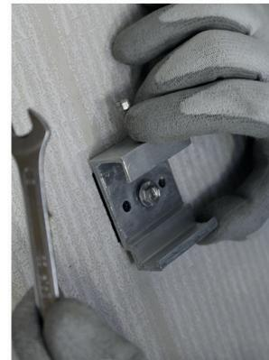
Die verstellbaren Clips tragen das Gewicht der Platten und tragen zusammen mit den festen Clips zum Windwiderstand bei.
